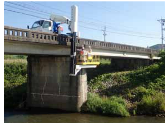
(橋梁側面の点検状況)
