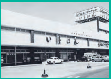
▲昭和47年12月に完成した 上市ターミナルビル
