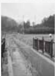
共通幹線水路
