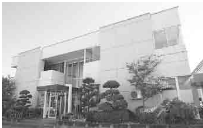
耐震補強工事が予定されている働く婦人の家
