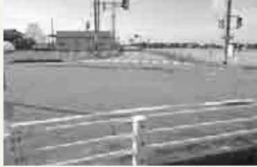
防護柵を新設した交差点
