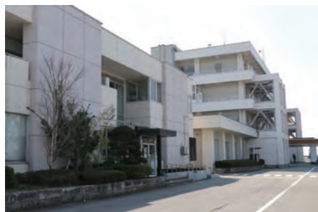
▲昨年度、耐震改修を行った働く婦人の家(写真左)
