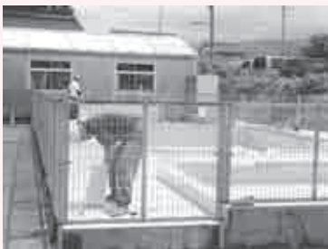
工事中のプール
