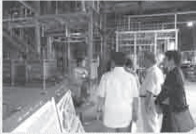
宮古島のエタノール製造設備
