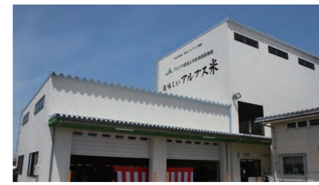
▲ 完成したJAアルプス上市乾燥調製施設(江上地内)
