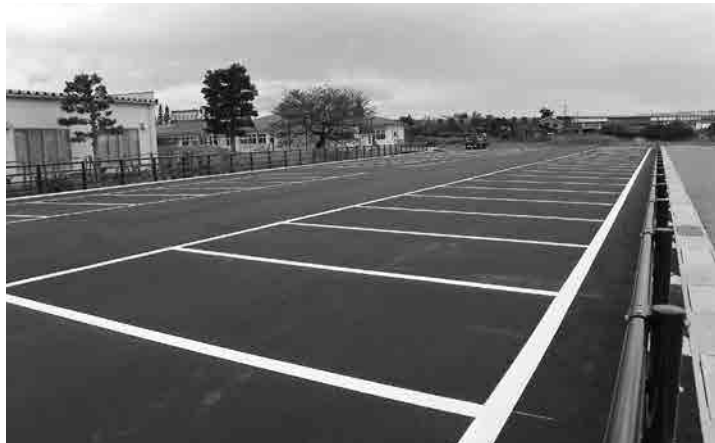
宮川こども園東側に駐車場を建設及び町道 東江上田園線を建設
