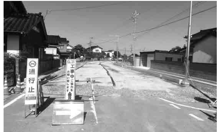
県道上市水橋線 道路線形改良工事
