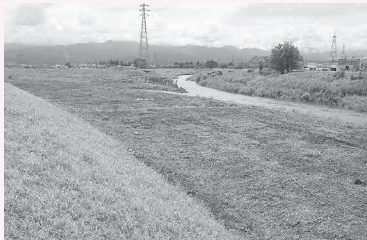
▼雑草雑木が除去された 白岩川と栃津川合流付近
