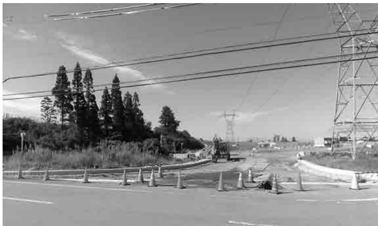
上市スマートインター 下り線出入口
