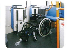
車いす固定装置
