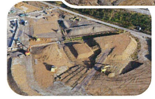
▲盛土工事の推進
