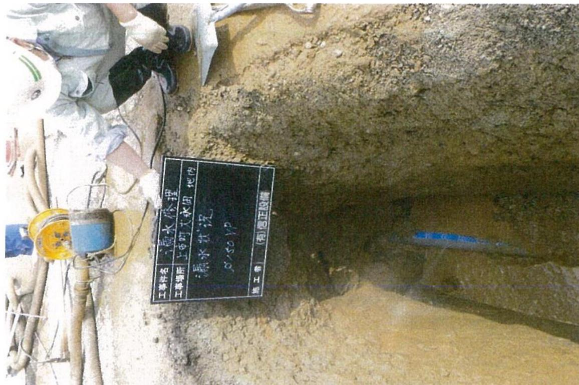
写真-2. 漏水写真
