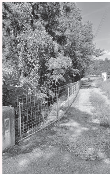
新設した動物侵入防止柵
