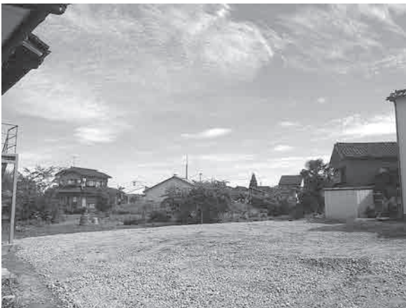
▼解体撤去完了
