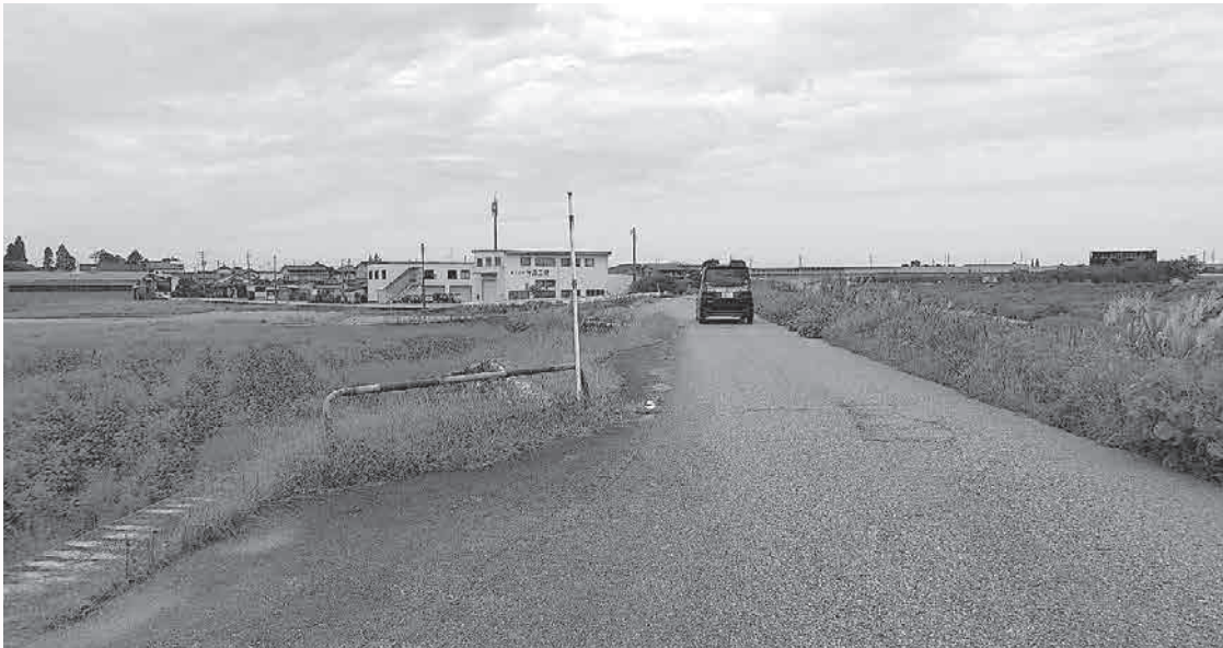
町道石仏・竹鼻線(上市川左岸の堤防道路)
