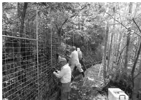
侵入防止柵を設置する地元の方々
