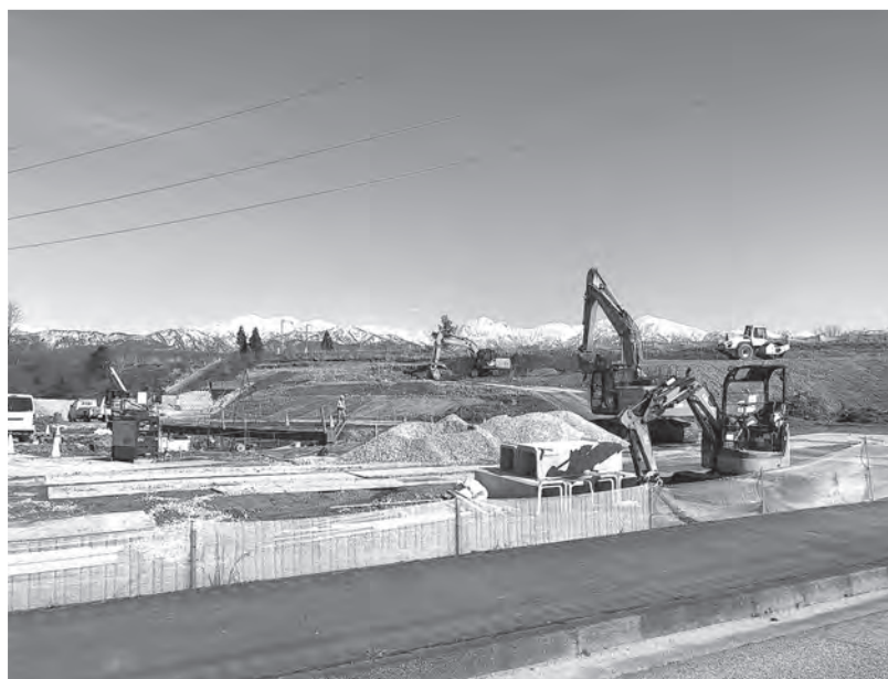
スマートインターチェンジ工事現場(中江上地内)
