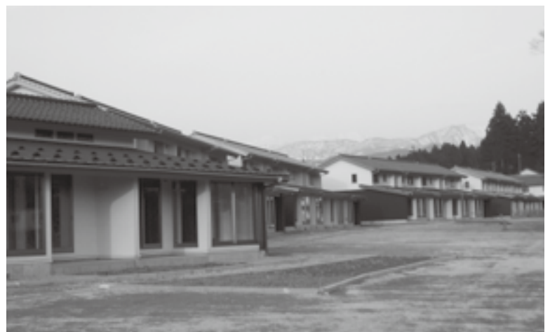
白萩西部町営住宅
