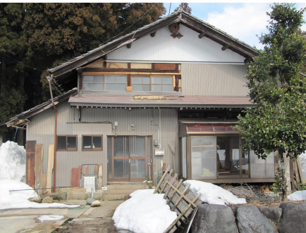
・外観: 玄関及びアプローチ(南西側)
