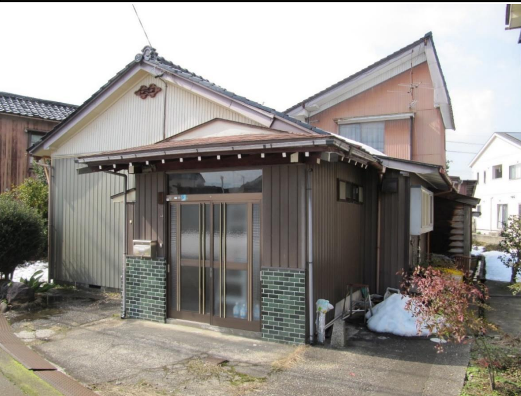
・空き家の外観(北東側)
