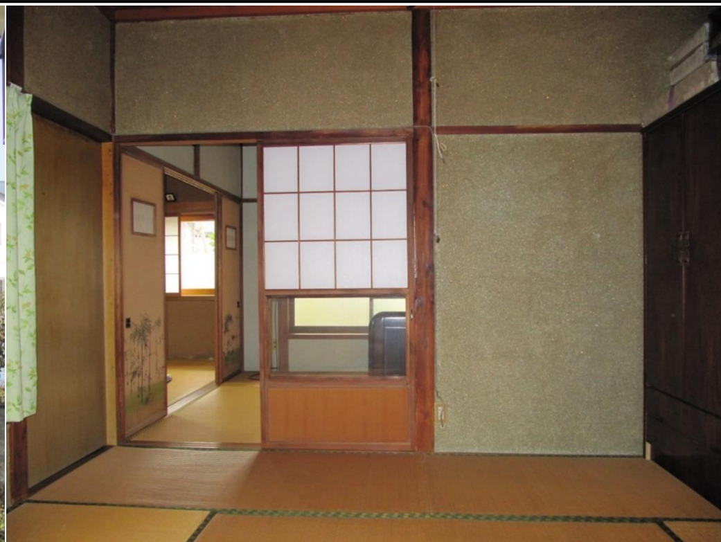
・空き家の内観(真壁造りの和室)
