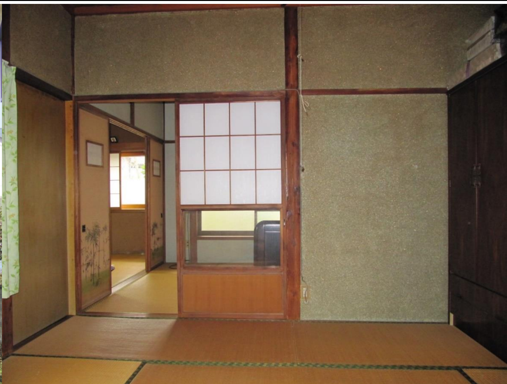
・空き家の内観(真壁造りの和室)
