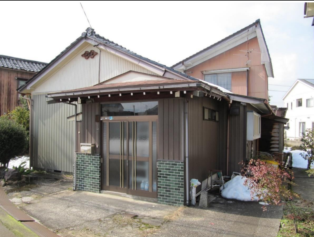
・空き家の外観(北東側)
