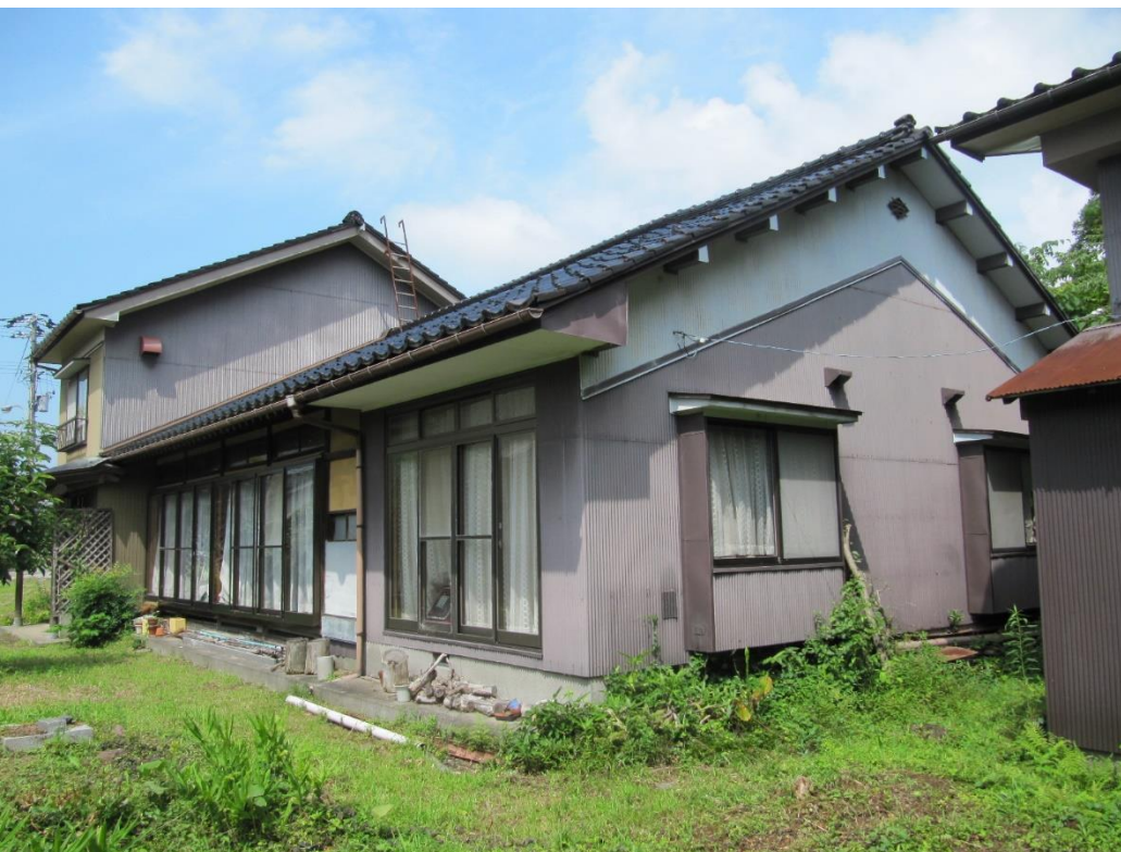
・空き家の外観(南西側)、延床面積:222㎡
