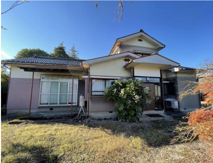
①住宅外観
