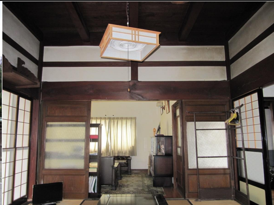
・空き家の内観(古民家構造である「枠の内造り」の1階和室)
