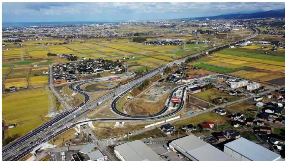
上市スマートインターチェンジ
