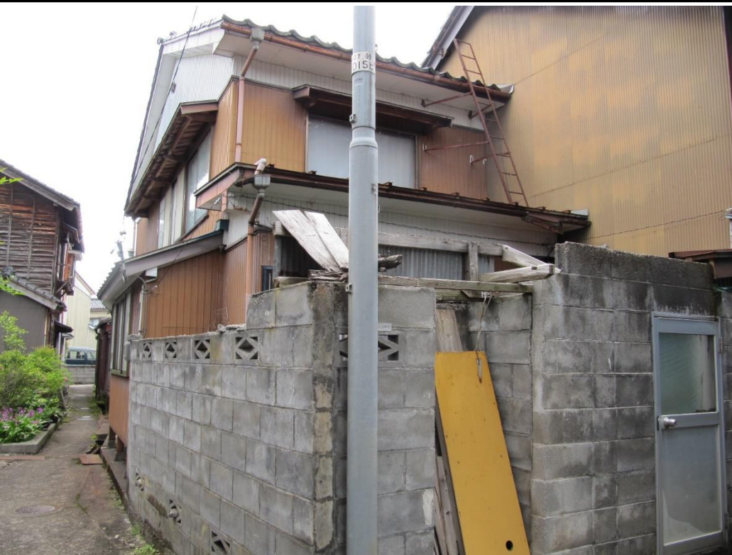
・空き家の外観(南側)
