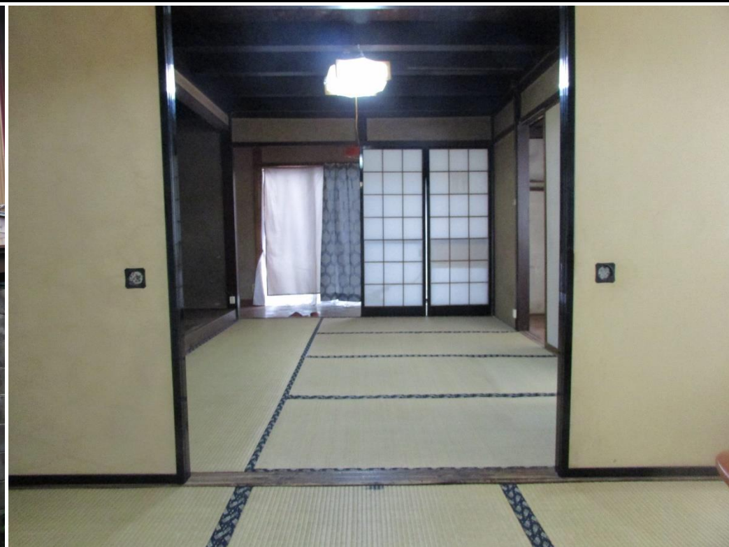
・空き家の内観(真壁造りの1階和室)
