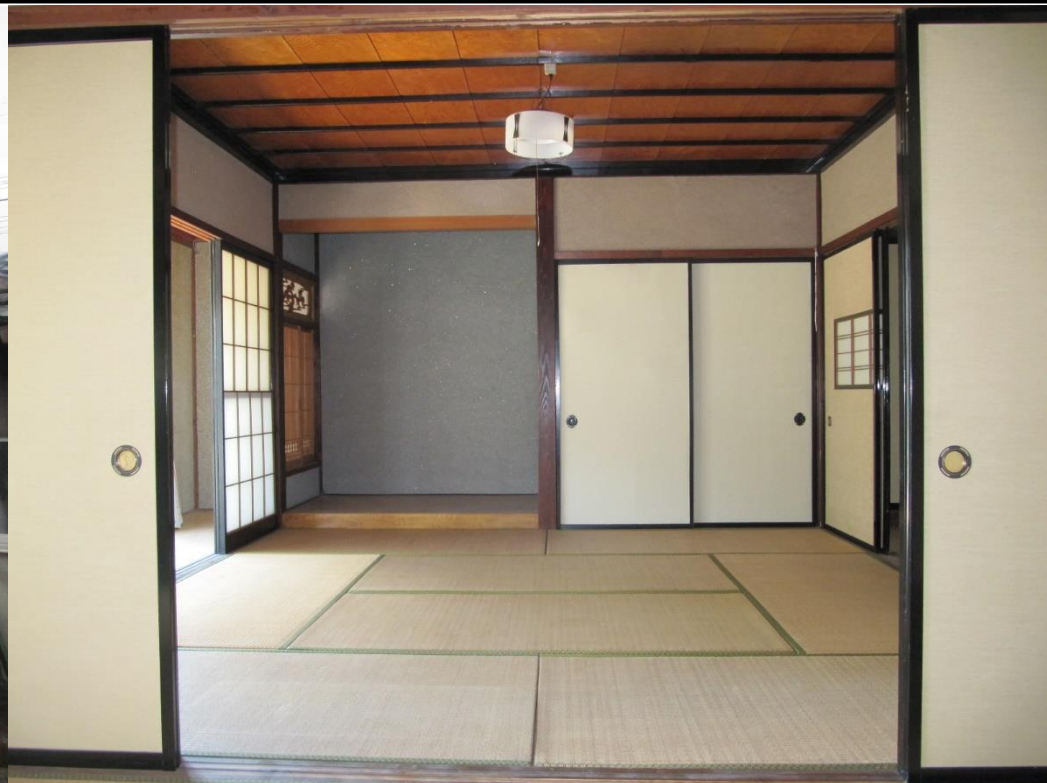
・空き家の内観（真壁造りの1階和室）
