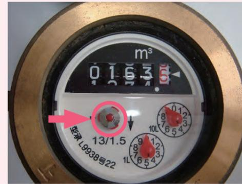
宅内の蛇口をすべて閉め、メーターボックス内の水道メーターを確認してください。銀色のコマが回っていたら漏水の可能性があり、水道料金もかかりますので、早めに町指定の水道工事店への修理依頼をお願いします(修理費用は自己負担です)。
