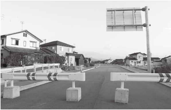
工事中の横越荒田線
