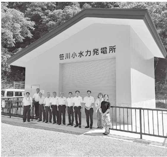
笹川小水力発電所 (朝日町笹川地区)
