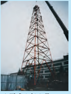
▲平成8年2月 温泉掘削開始。高いやぐらが建設され、掘削が開始されました。
