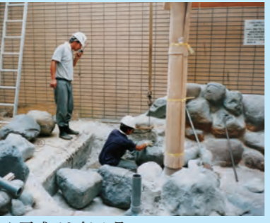
▲平成10年4月 建物の建設が完了し、露天風呂の石積み作業をしているところです。
