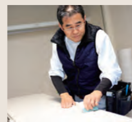
クロス・化粧フィルム貼り、フロアタイル・じゅうたん張りなど様々な種類の仕事をこなす奥さん。壁や建具などで使用する化粧フィルムの施工に高い技術を持つ。
