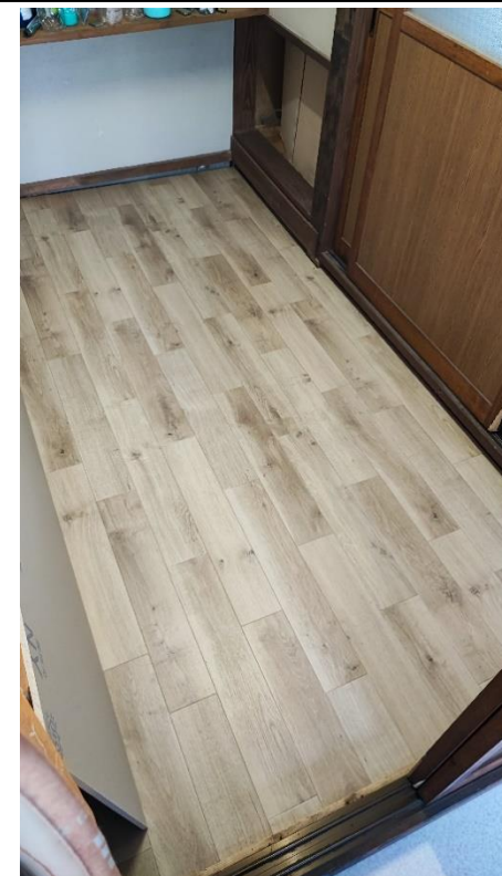
・内観(床を改修)
