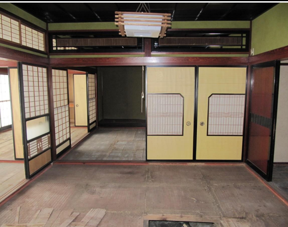
・空き家の改修前の内観
