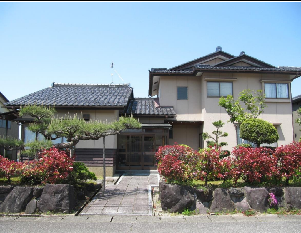
・空き家の外観(東側)
