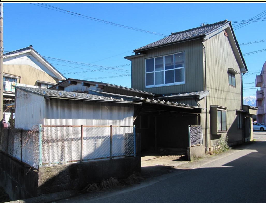
・空き家の外観(南西側)
