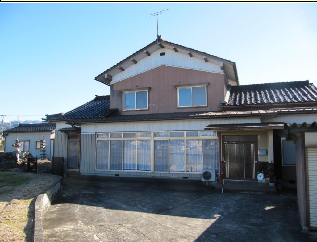
・空き家の外観(北側)
