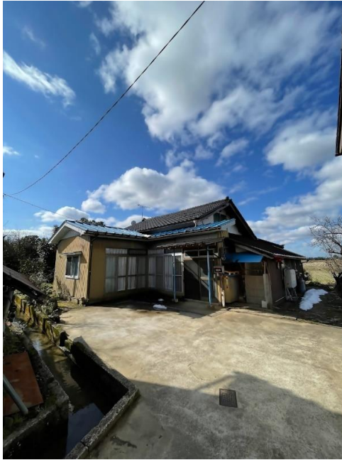
①住宅外観
