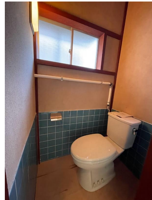
⑨1階トイレ
