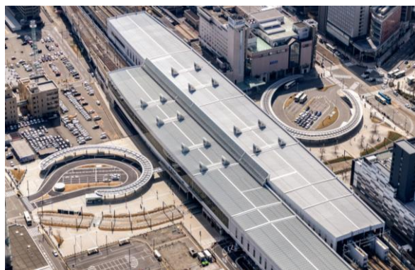
駅北口駅前広場の整備
