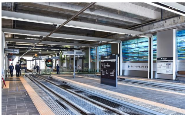
路面電車の南北接続
