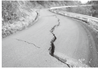
令和6年能登半島地震により亀裂が入った林道黒川線
