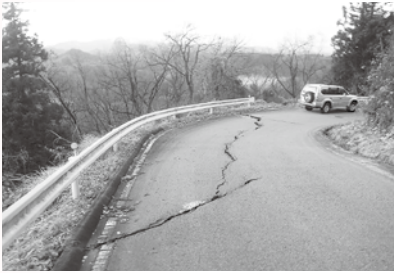
令和6年能登半島地震により亀裂が入った林道黒川線
