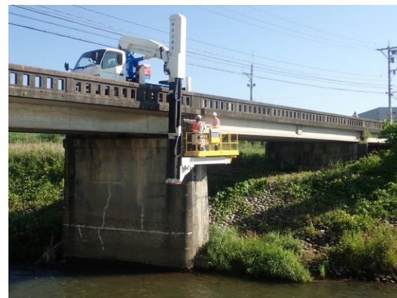
(橋梁側面の点検状況)
