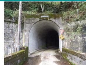
(稲村トンネル起点側坑門)
