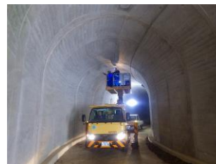
(トンネル覆工の点検状況)
