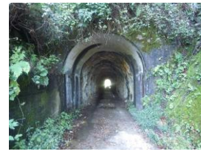
(田蔵トンネル起点側坑門)
