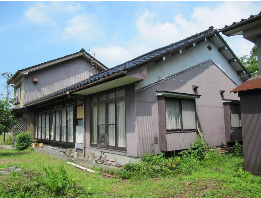
・空き家の外観(南西側)、延床面積:222㎡
