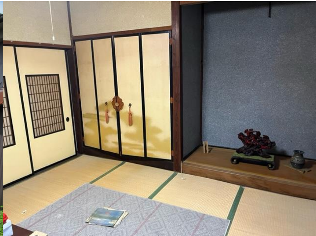
・空き家の内観(真壁造りの1階和室)
