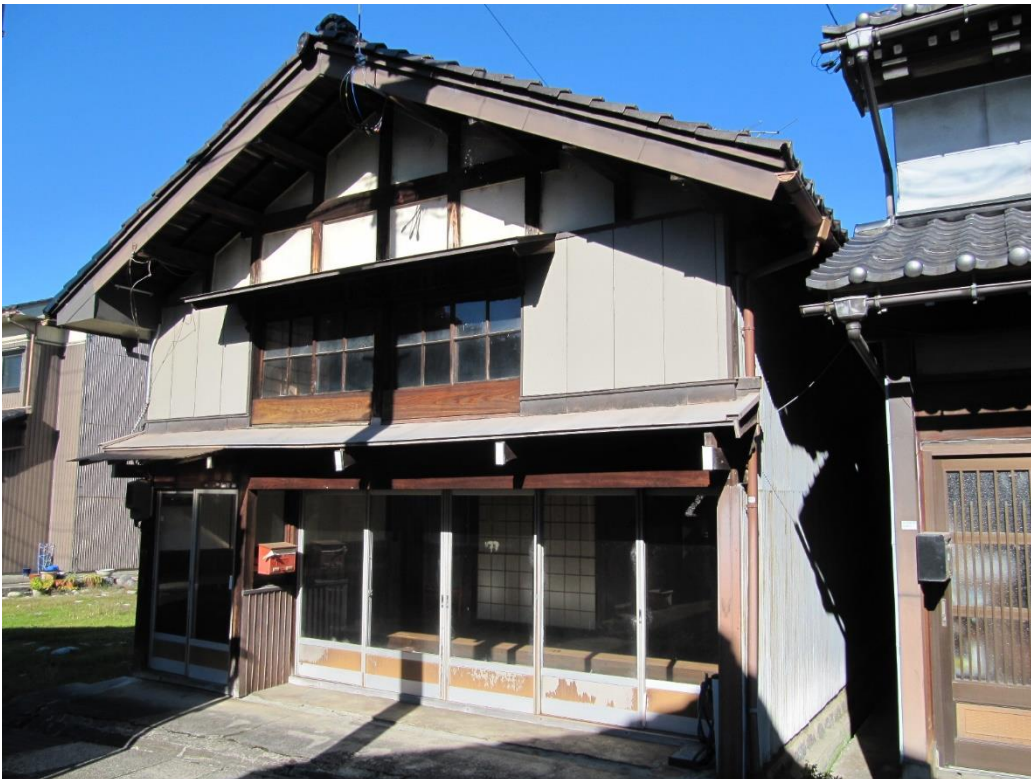
・空き家の外観(南西側)、延床面積:218㎡
