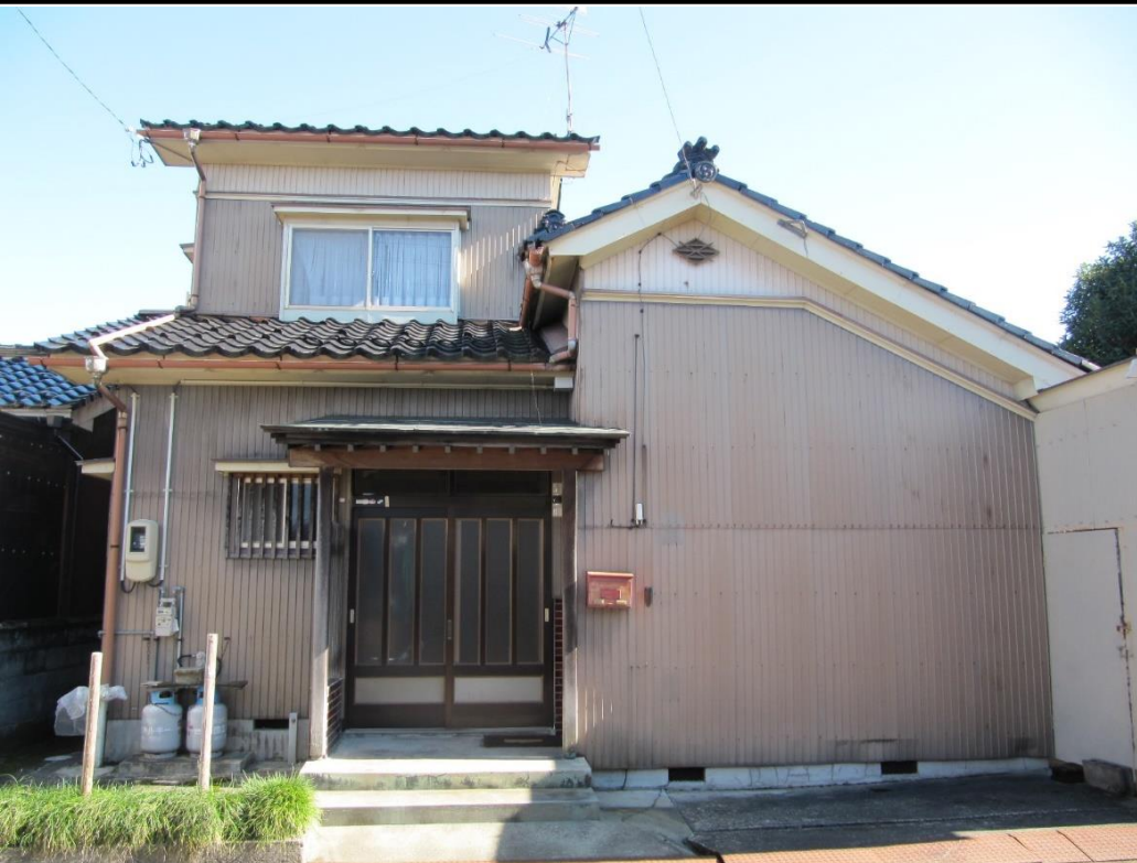
・空き家の外観（北東側）、延床面積：168㎡
