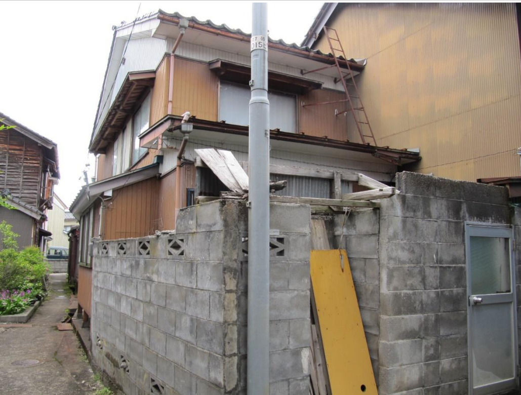
・空き家の外観(南側)
