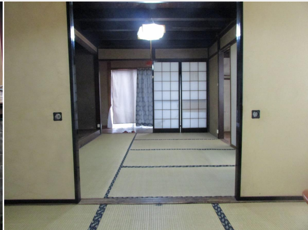
・空き家の内観(真壁造りの1階和室)
