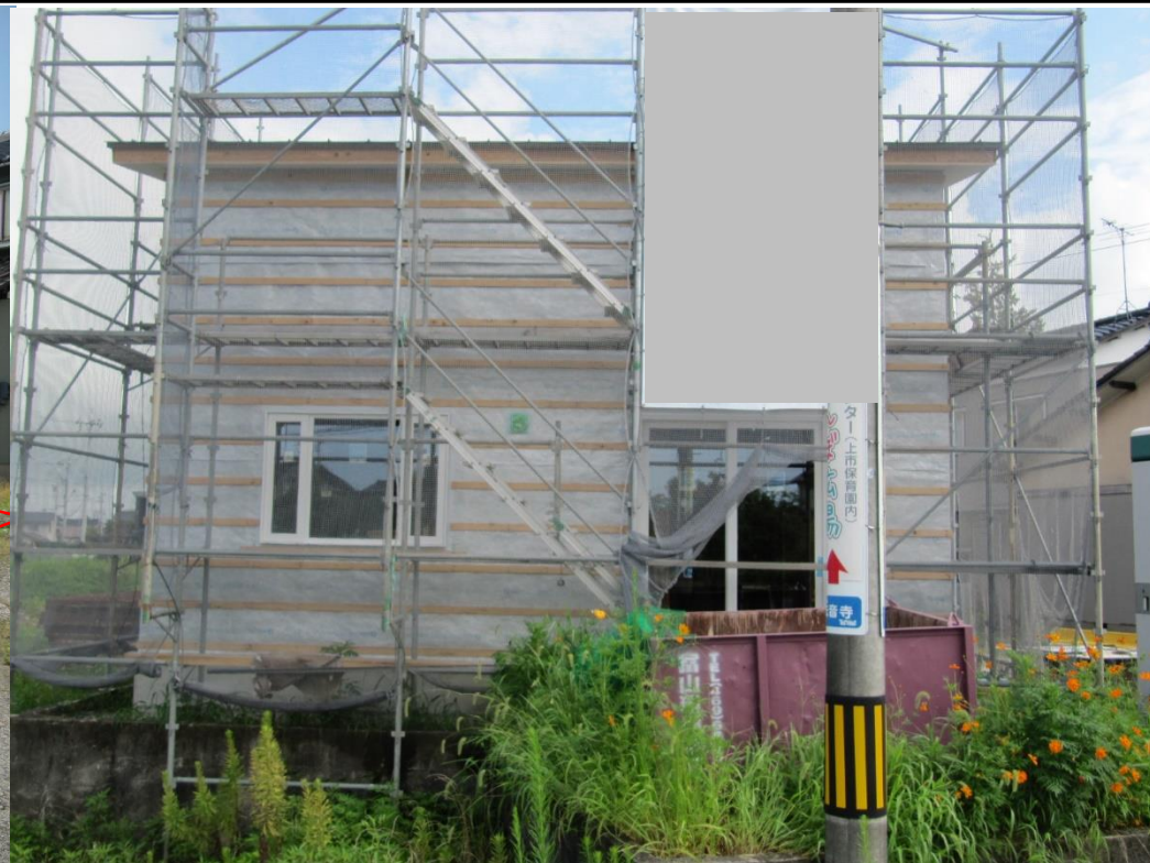
・住宅を新築中(南側)
