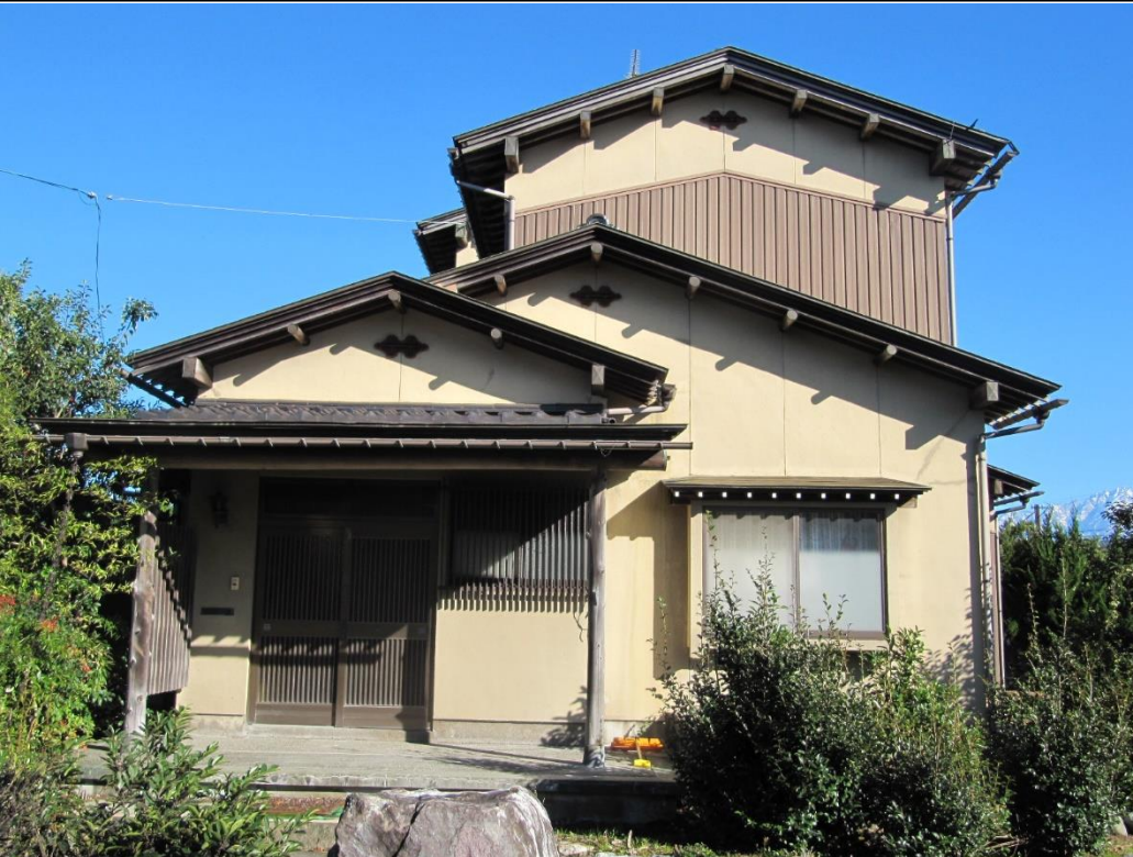
・空き家の外観(南西側)
