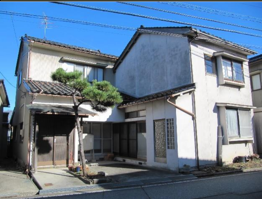
・空き家の外観(西側)
