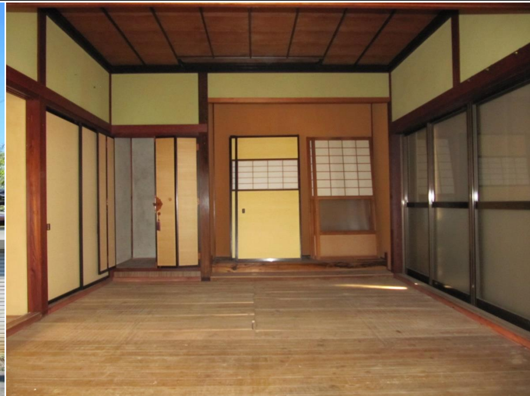
・空き家の内観(1階和室)
