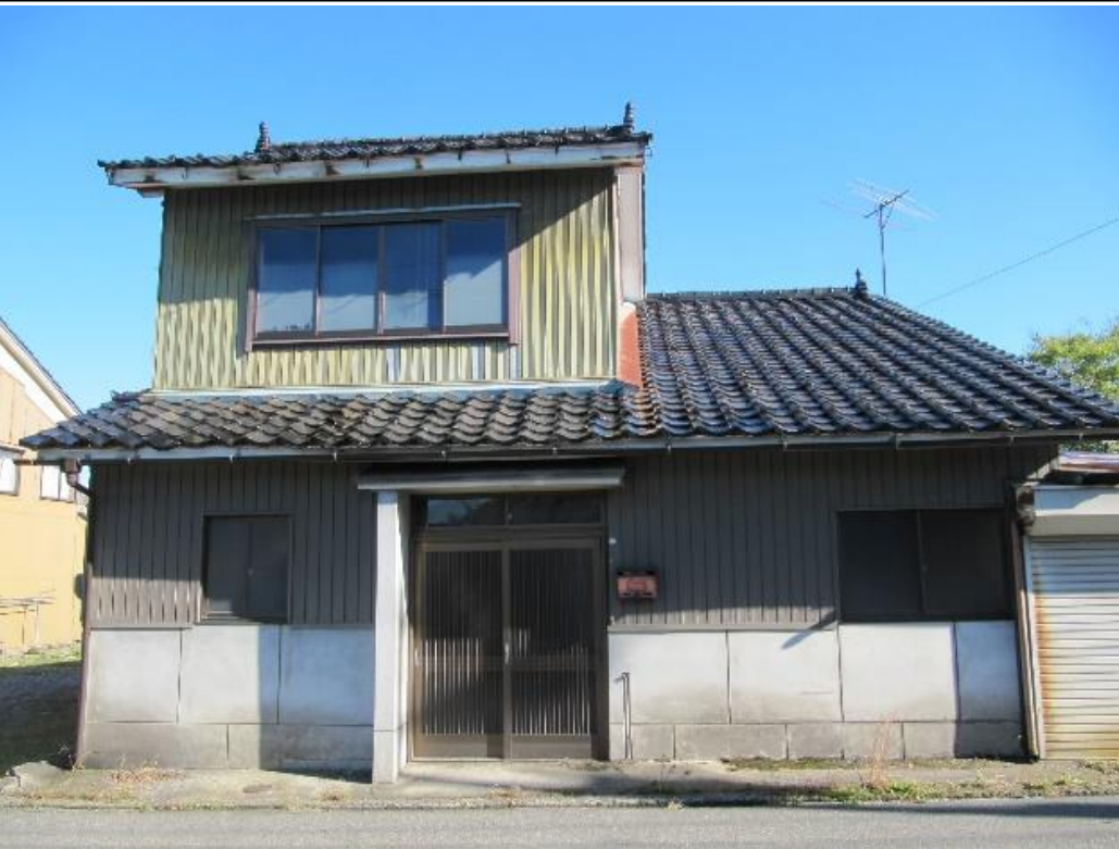
・空き家の外観(西側)
