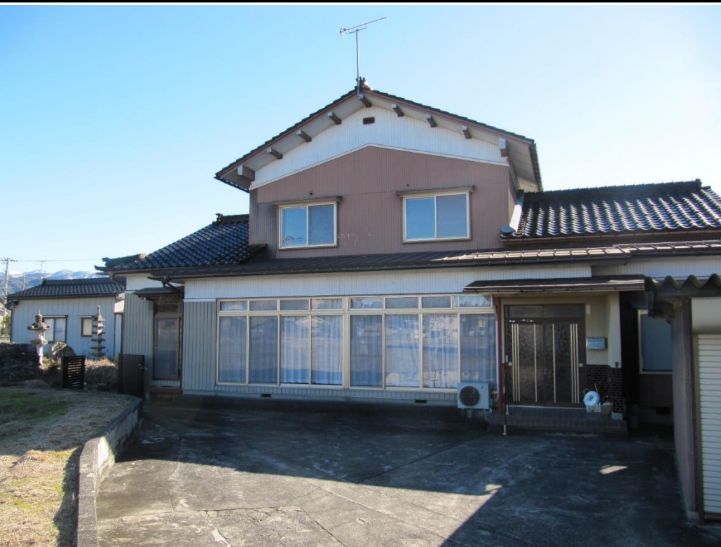
・空き家の外観(北側)
