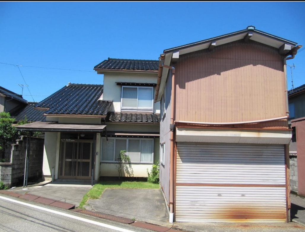
・空き家の外観(南側)
