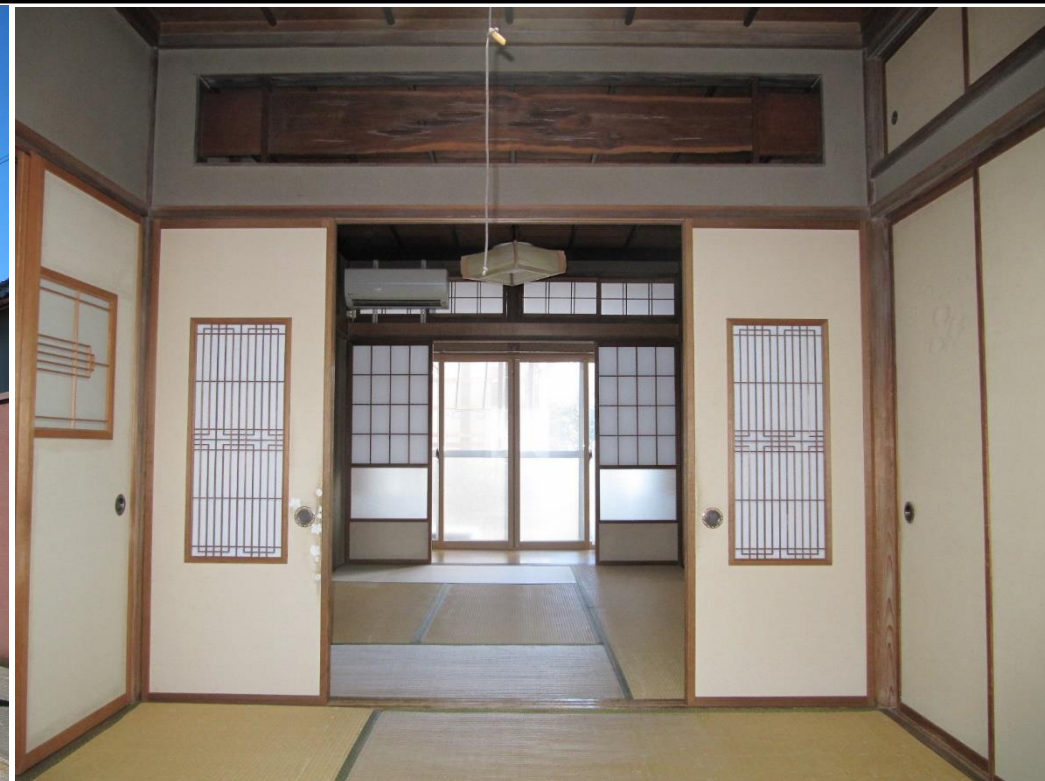
・空き家の内観(真壁造りの1階和室)
